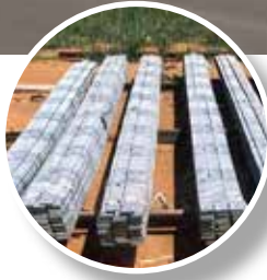
Çelik / Geosentetik Donatı Şeritleri veya Geogrid (ArmaGrid®) Donatı
